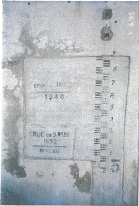
Echelle de crues du pont Joffre sur la Têt à Perpignan Marques du 18/10/1940 et du 09/11/1892
