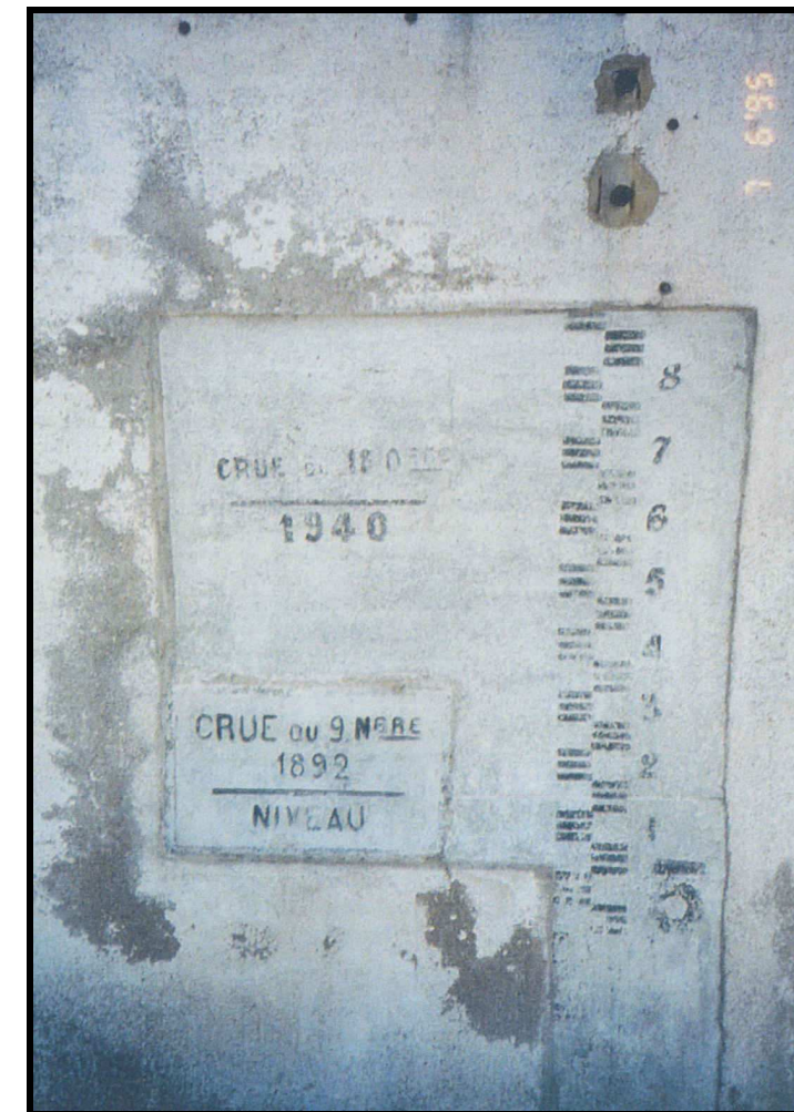
Echelle de crues du pont Joffre sur la Têt à Perpignan Marques du 18/10/1940 et du 09/11/1892
