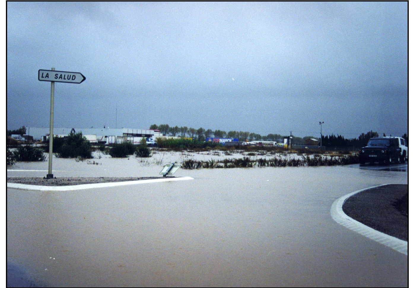
L'aval de la RN 9 après la crue de novembre 1999
