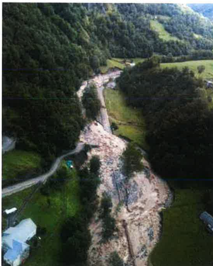
Pont de Viey face au village de Betpouey, juin 2013 (Photographie diffusée sur le site "cycloblog")
