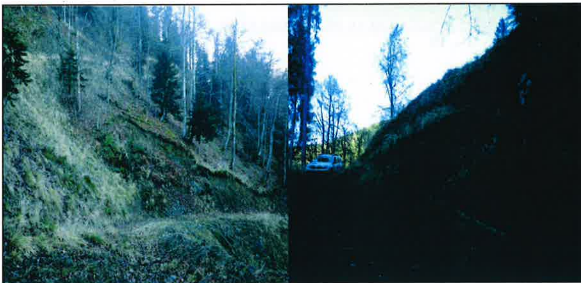
Figure 14: Glissements sur la piste de Bios (source AGERIN)
