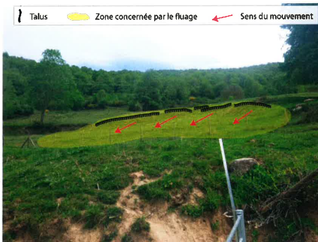
Figure 6: Signes de fluage autour de la parcelle n°56 au nord du village (Source : AGERIN SAS)
