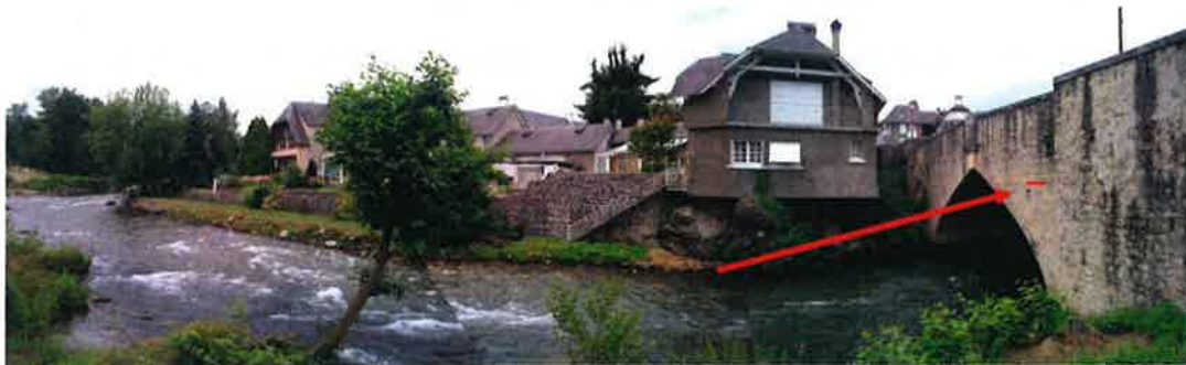
Figure 76 : repère de la crue (trait rouge) du 23 juin 1875 ; face amont du pont de Montgaillard
