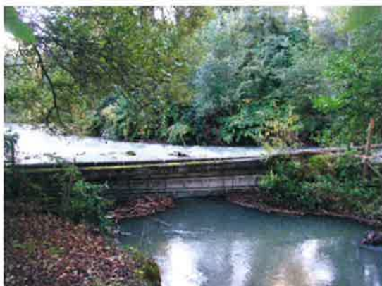
Prise d'eau du canal de Salles-Adour
