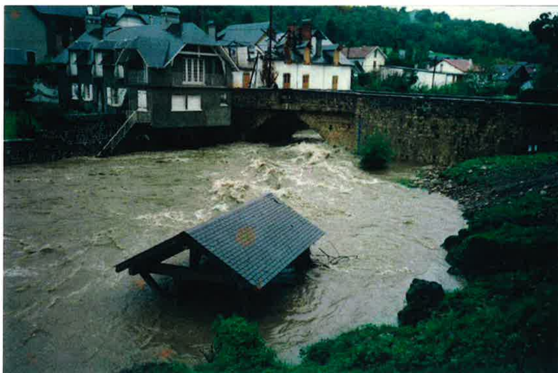
Crue du 5 novembre 1992 à Montgaillard
