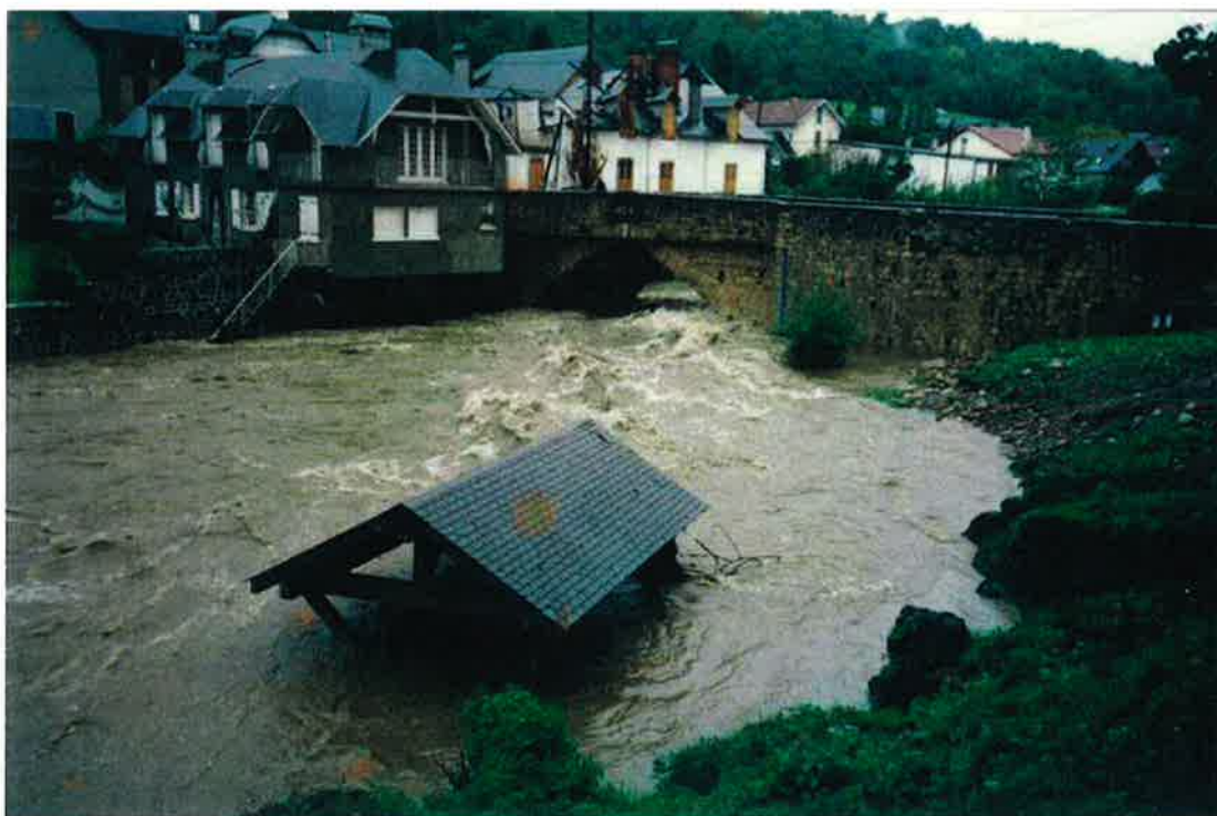
Crue du 5 novembre 1992 à Montgaillard
