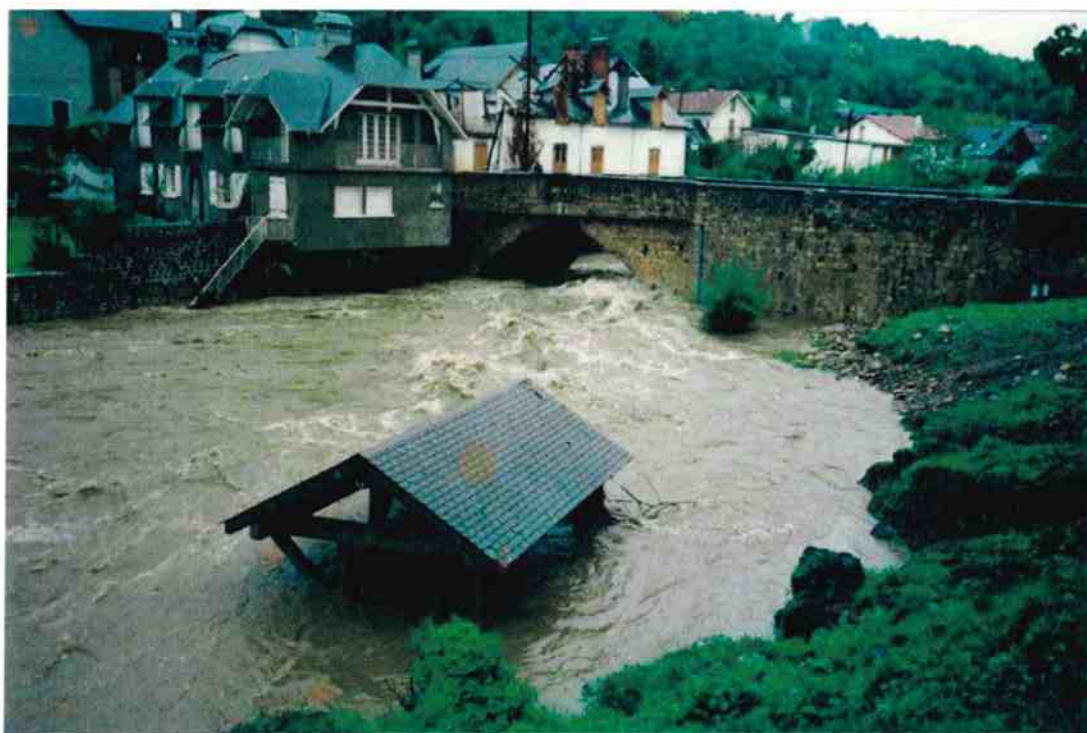
Crue du 5 novembre 1992 à Montgaillard
