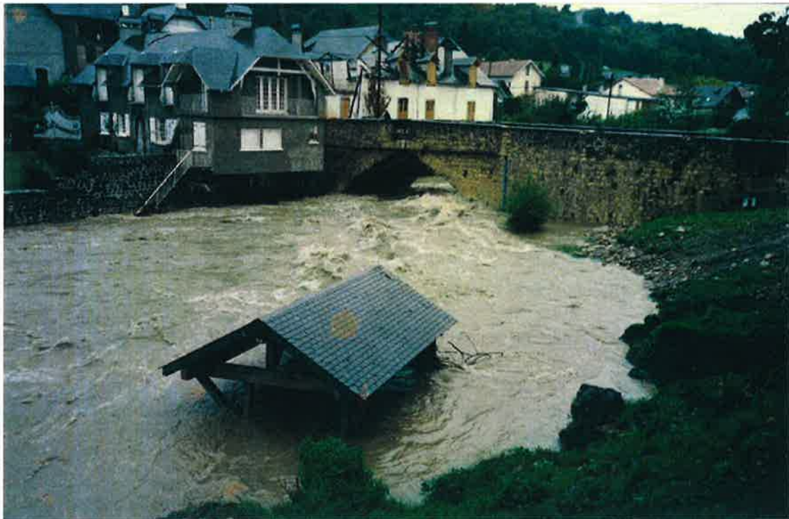
Crue du 5 novembre 1992 à Montgaillard
