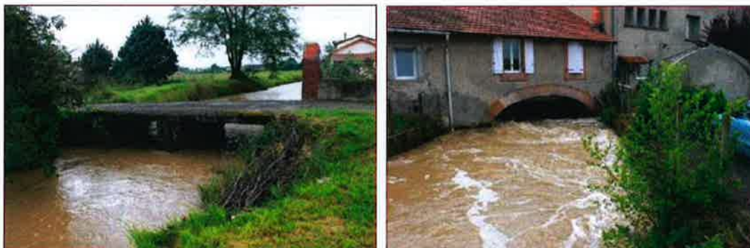
Alaric – Point de contrôle hydraulique entre la prise d'eau et le premier moulin
