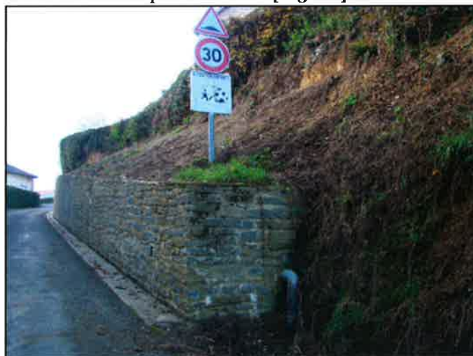
Figure 35: Confortement en aval du cimetière [Source : IMS RN ]
