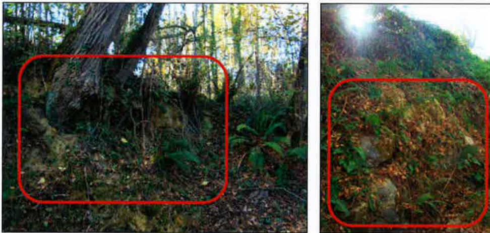
Figure 33 : Talus instable (à gauche) et enrochement (à droite) dans le secteur du Barrat [Source : IMS RN ]
