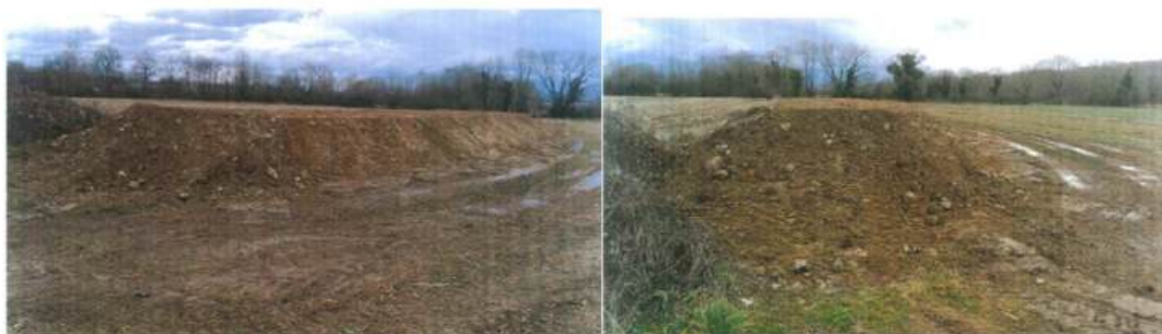
Photos du merlon en construction à Lée
