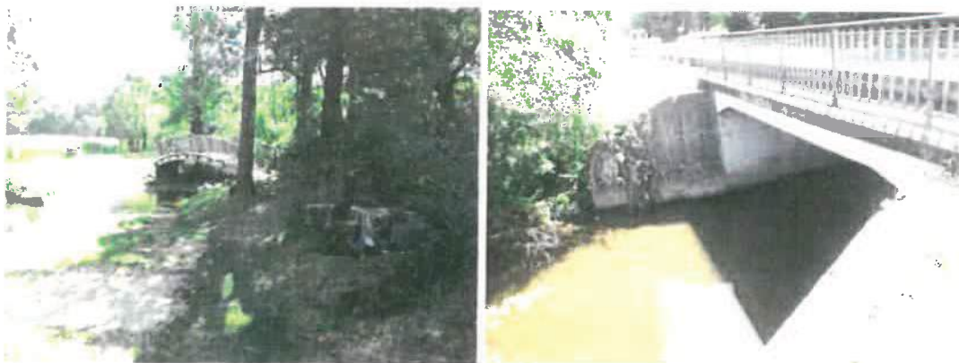
Figure 43 : L'Arriou Merdé - Passerelle Juyou et RD 938
