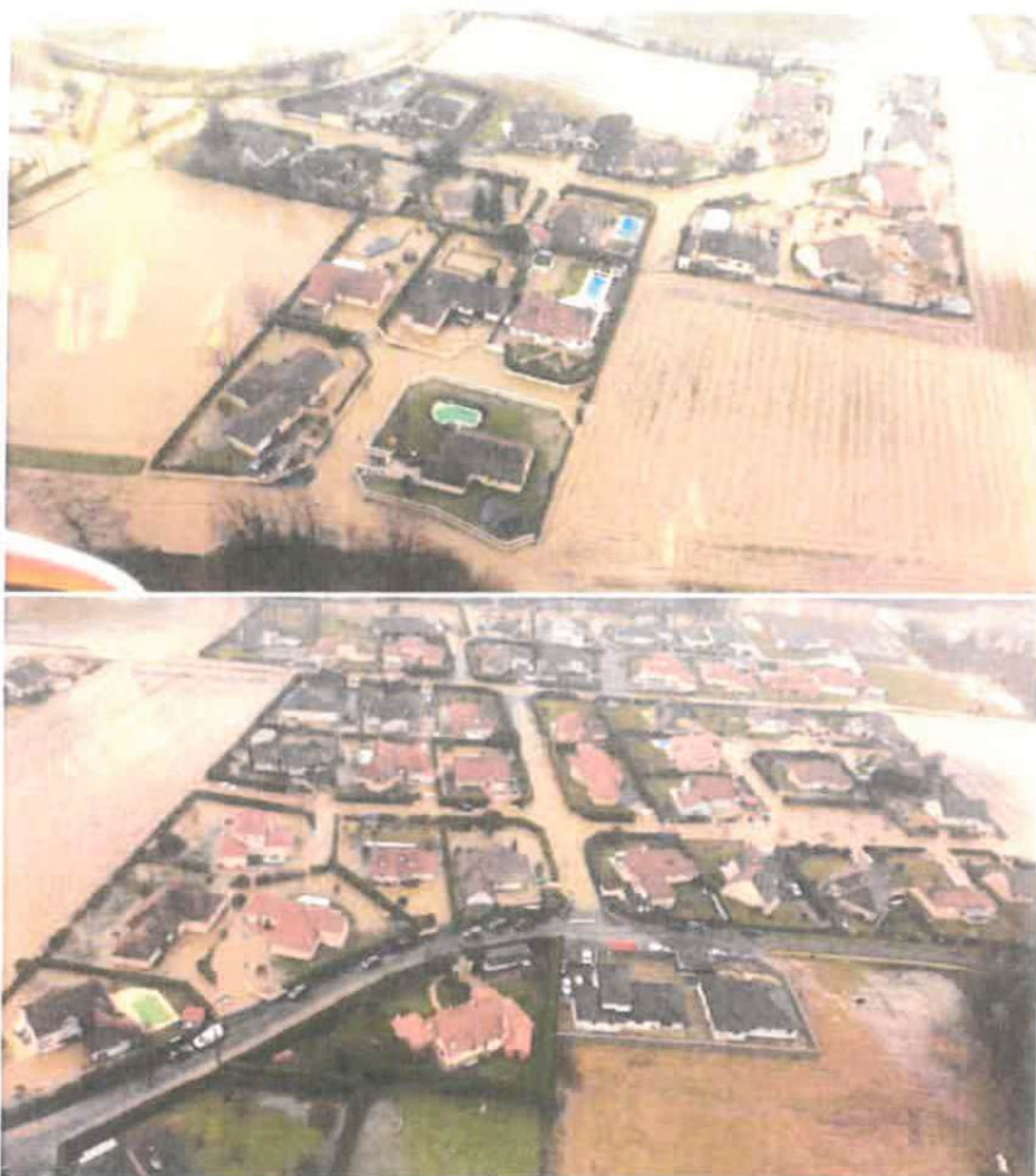
Figure 47 : L'Ousse lors de la crue de janvier 2014 chemin des Cambets (source SDIS64)
