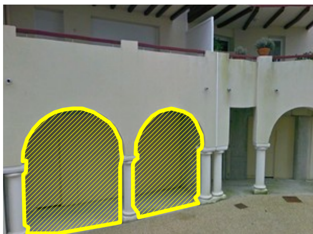
Obturation d'une travée de galerie
