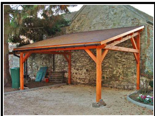
Construction annexe adossée
