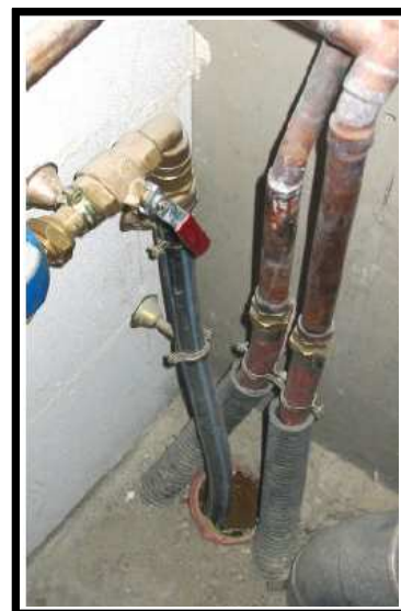
Calfeutrage des entrées de réseaux
