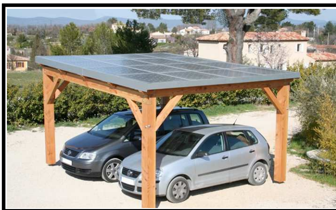
Construction annexe non contiguë
