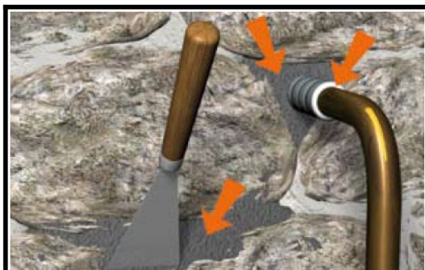
Situation après travaux de colmatage
