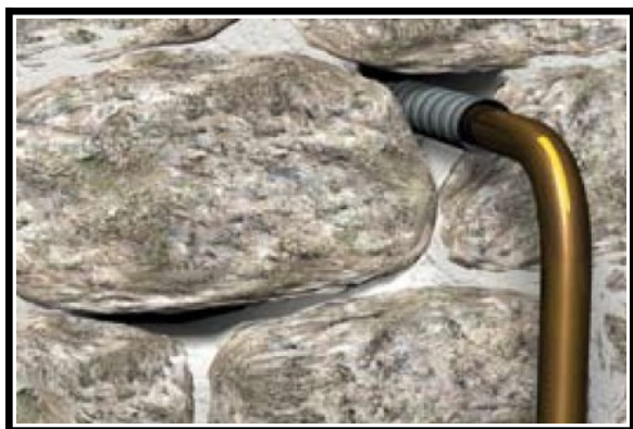
Situation initiale avant colmatage
