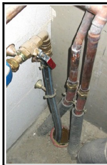
Calfeutrage des entrées de réseaux
