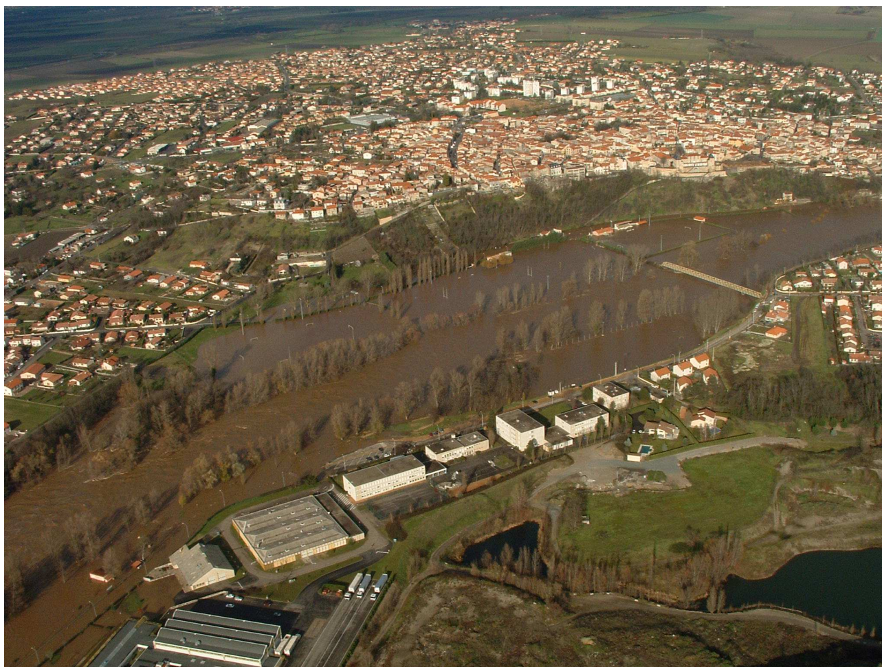
Crue des 3 et 4 décembre 2003 à Pont-du-Château
