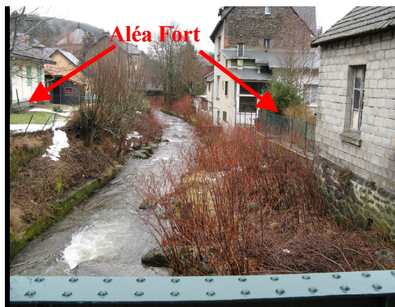
Photo 2 : zonage de l'aléa fort (secteur en aval du Casino) (photo BCEOM)
