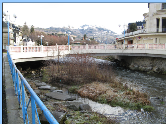
Photo 9 : section hydraulique diminuée par la présence d'un îlot en cour de végétalisation (photo BCEOM)
