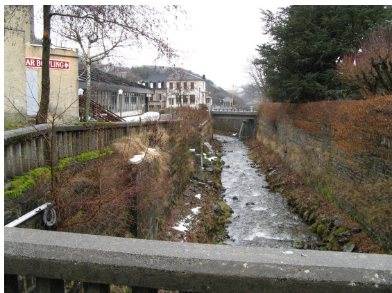
Photo 3 : canalisations de la Dordogne (capacité supérieure à la crue centennale) (photo BCEOM)
