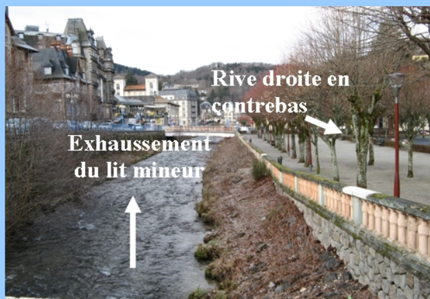
Photo 7 : canalisation de la Dordogne et mise en place d'un lit en toit. (photo BCEOM)
