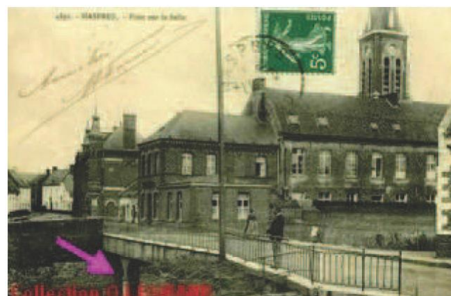
Reprofilage et élargissement du pont en 1880. Ce dernier présente une armature d'acier recouverte de pavés. Le pont est dynamité pendant la guerre en 1918.
