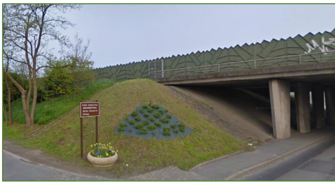
Le remblai de l'autoroute A2 à Douchy-les-Mines
