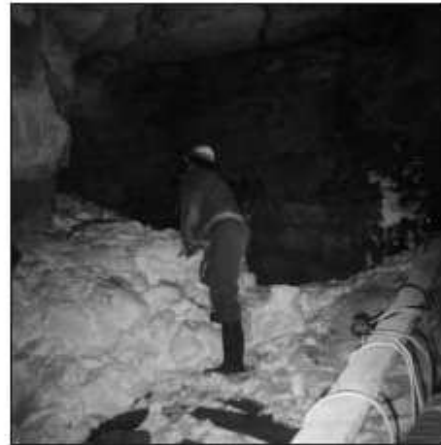
Injectée sous pression par des canalisations en PVC, la mousse durcit rapidement et comble les vides.
