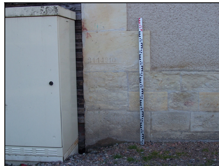
Figure 2: Repère de crue daté du 21 janvier 1910 sur le gymnase de Guérigny.
