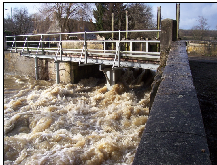
Figure 1: L'empellement de la Poëlonnerie (commune de Guérigny).
