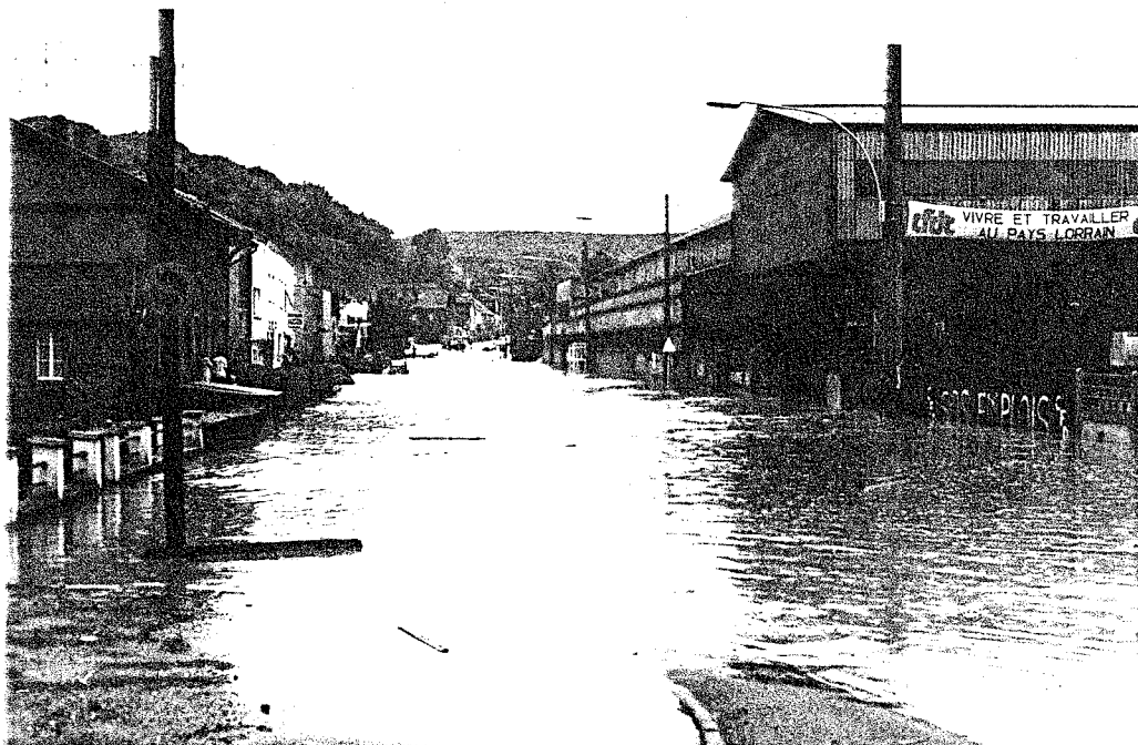
la RN 3 et l'ancienne usine Munch
