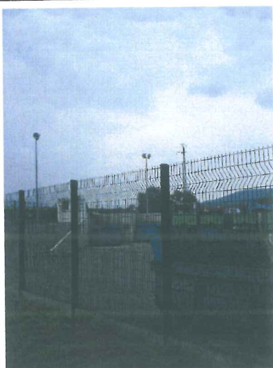
Déchetterie Photo : CETE de l'Est
