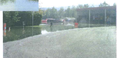
Stockage de sel de déneigement (crue oct.2006) Photos : Commune de PONT-A-MOUSSON
