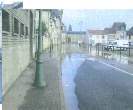
Abbaye des Prémontrés vue de la rue Saint Martin - crue 2006 Photo : Commune de PONT-A-MOUSSON
