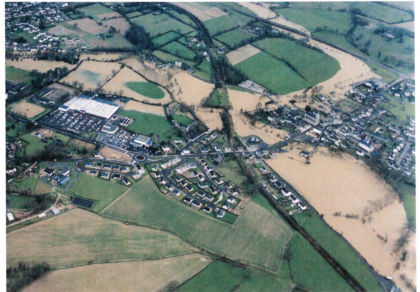
Ste-Gemmes-d'Andigné – crue de 1995 – Photo Edange
