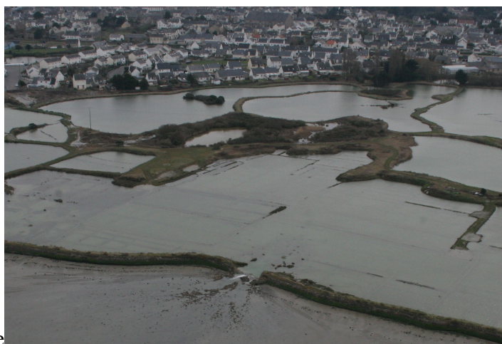
Brèche de digue dans les marais salants de Guérande lors de la tempête Xynthia.
