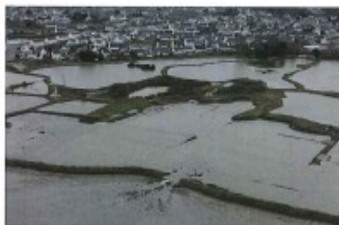
Brèche de digue lors de la tempête Xynthia
