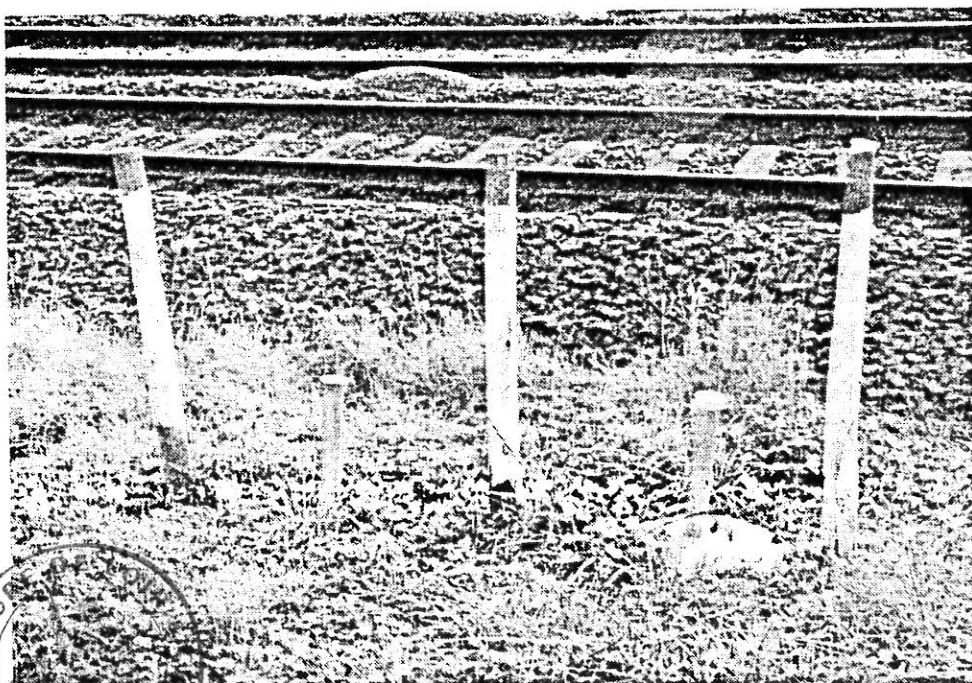
Mise en place du piézomètre en bordure de la voie ferrée
