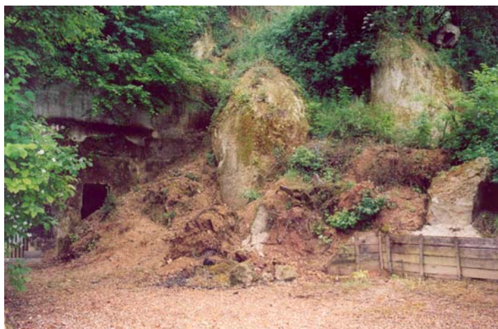
Cône de matériaux meubles ayant glissé le long du coteau
