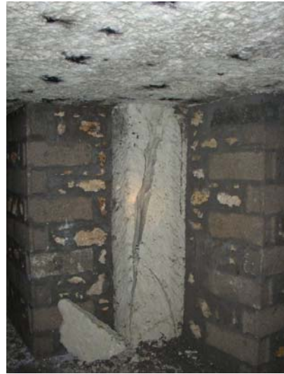
Dans certaines zones, le recours à des étais en maçonnerie a donc été nécessaire.
