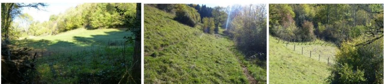
Figure 7: partie nord-est de la zone d'aléa ; rupture de pente liée au pied de la zone d'éboulis, reptation et clôture en cours de bascule.
