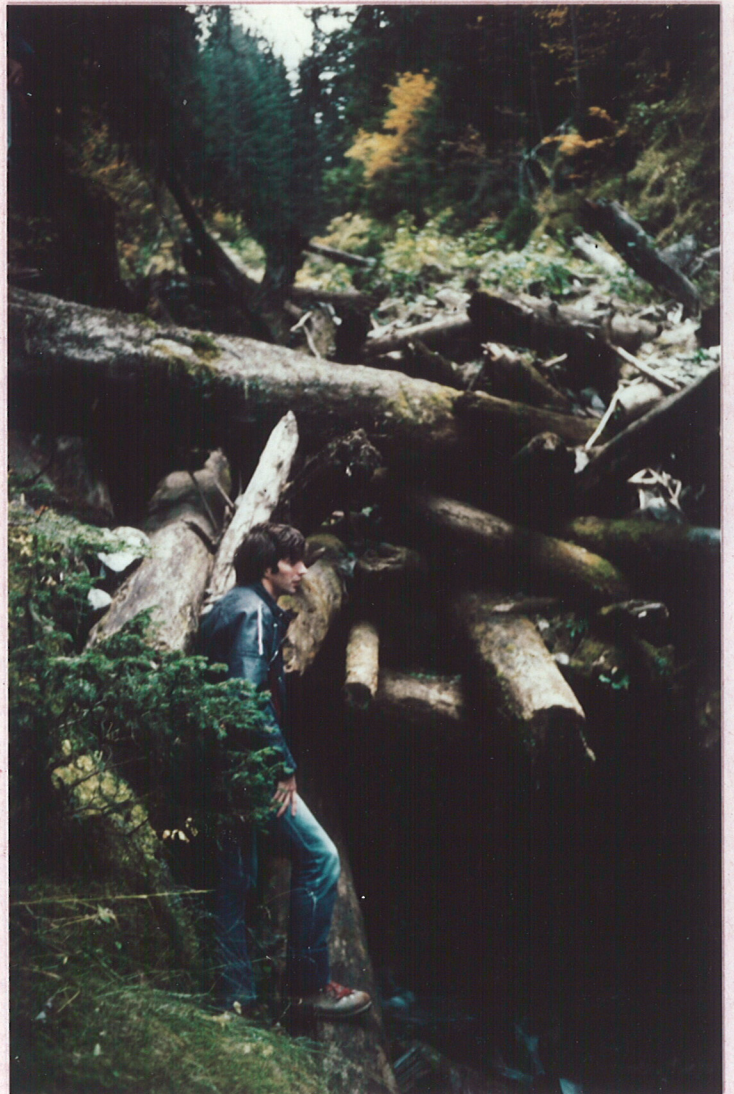
barrage de troncs dans le lit du torrent de Malentraz.
