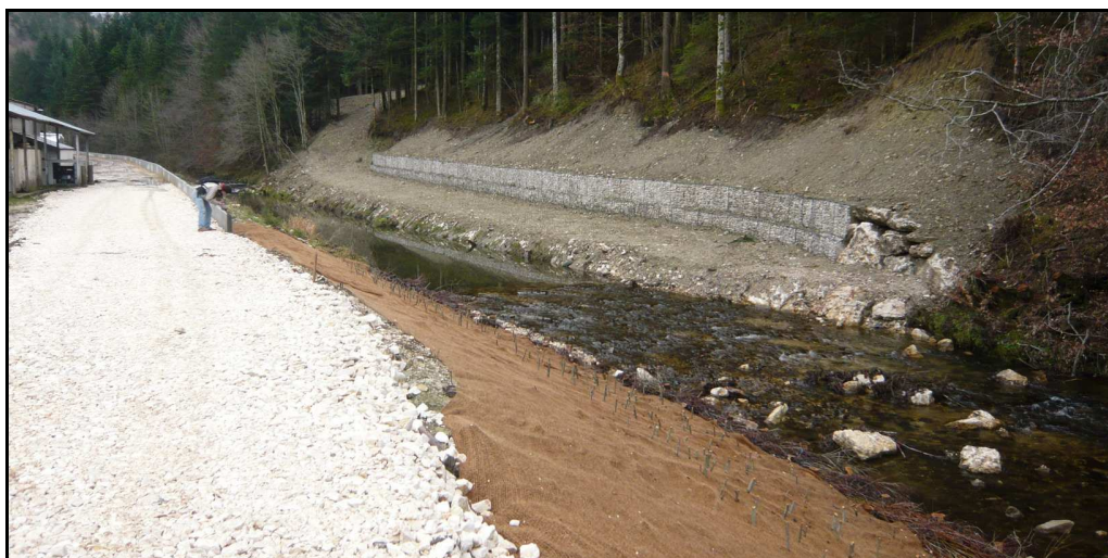
Vue sur les protections de berges de la Bourne au niveau de la Zac des Fenat
