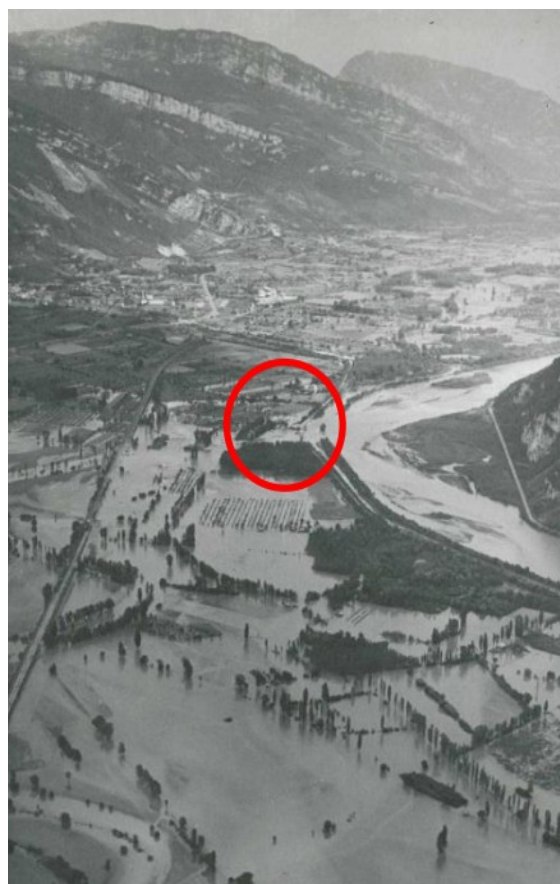
Illustration 8 : exemple de rupture de digue de l'Isère au Bec de l'Échaillon en 1948 – Source ADIDR
