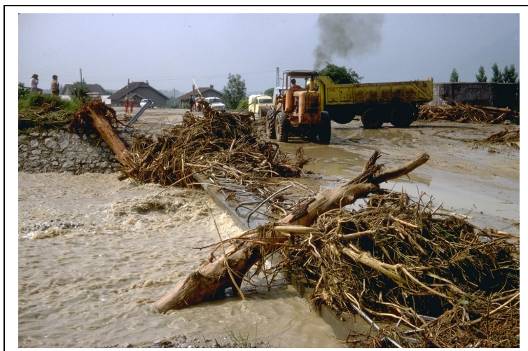
Pont de la route nationale 75 pendant la décrue, en juillet 1971. Noter l'obstruction presque totale du pont par les matériaux (cailloux et flottants)
