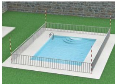
Piscine privée équipée d'une barrière de sécurité
