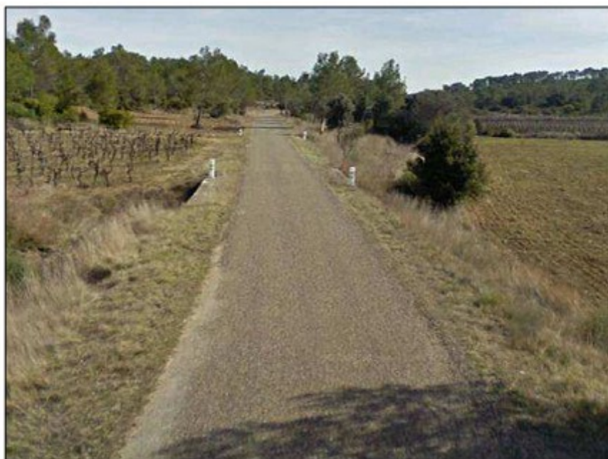
Franchissement de la RD 107 par le Vallat des Conques
