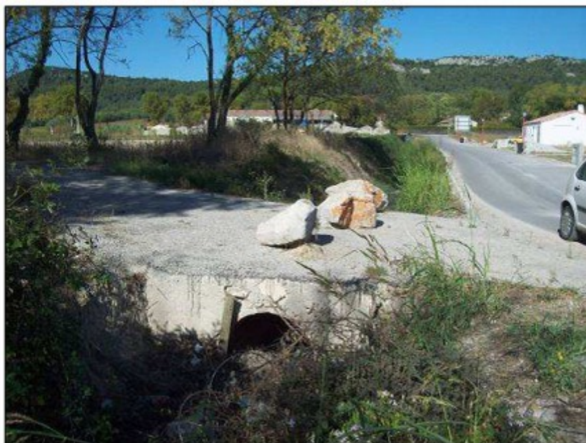
Fossé pluvial à proximité du nouveau lotissement
