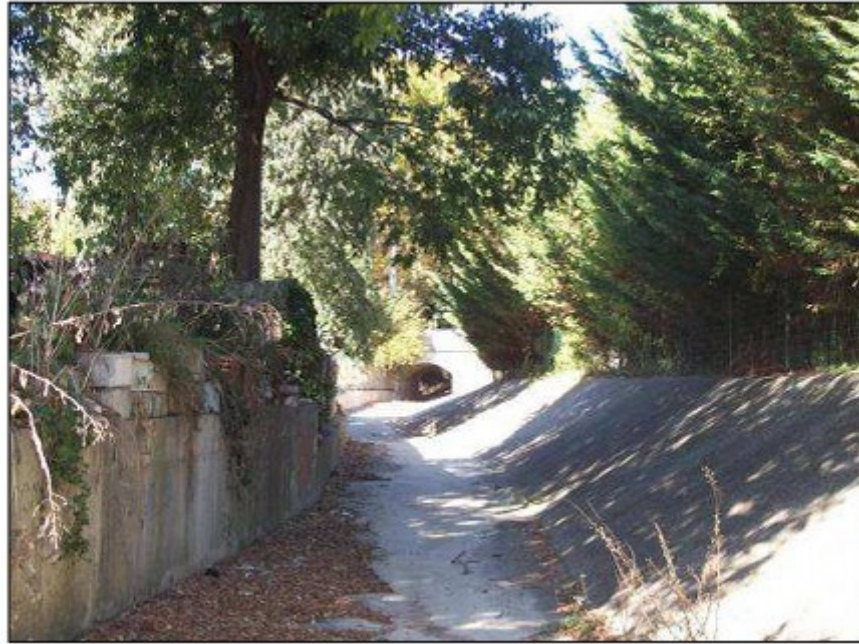
Le pont de la RD 120 et la section cuvelée du lit
