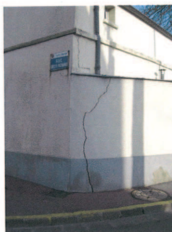
Figure 13 : Désordres liés au retrait gonflement des argiles. Source : extrait de Sécheresse et construction ; guide de prévention, 1993.
