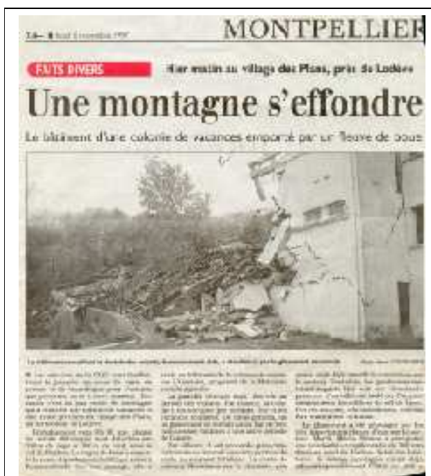
Figure 32 : Coulee de boue au Col du Perthus (commune des Plans): extrait de presse montrant l'ampleur de la destruction du bâtiment accueillant le dortoir des enfants, heureusement vide.
