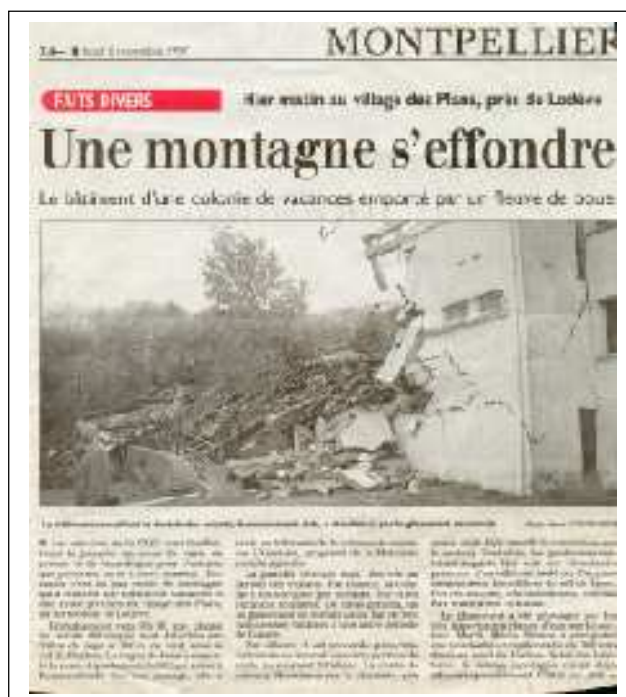
Figure 32 : Coulee de boue du Col du Perthus (commune des Plans): extrait de presse montrant l'ampleur de la destruction du bâtiment accueillant le dortoir des enfants, heureusement vide.
