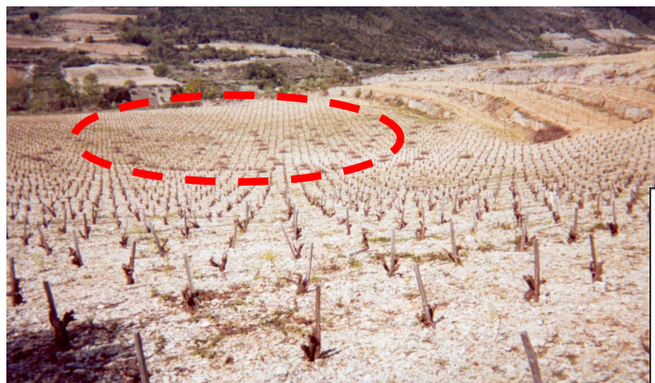
Affaissement dans une vigne en amont du glissement dit « Le Bétessier » à Pégairolles de l'Escalette.
