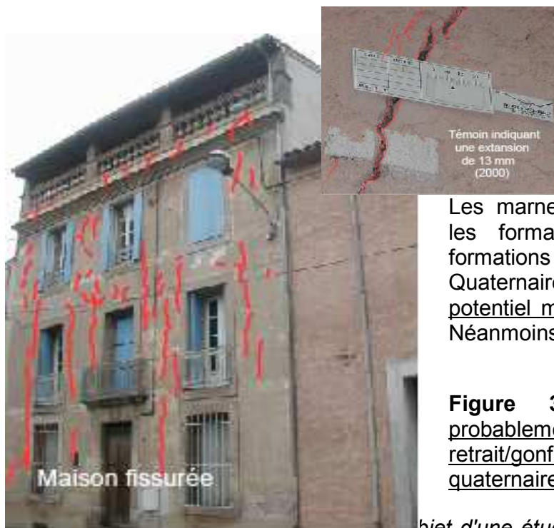
Figure 37 : Exemple de désordres sur une construction dus à la variation d'épaisseur du sol argileux sensibles.
