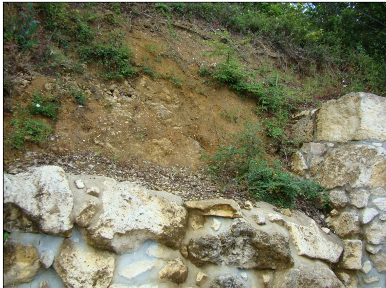
Fig. 6 : Affleurement d'éboulis en bordure du plateau, au Nord de la carrière Eiffage [Source : Ginger CEBTP]
