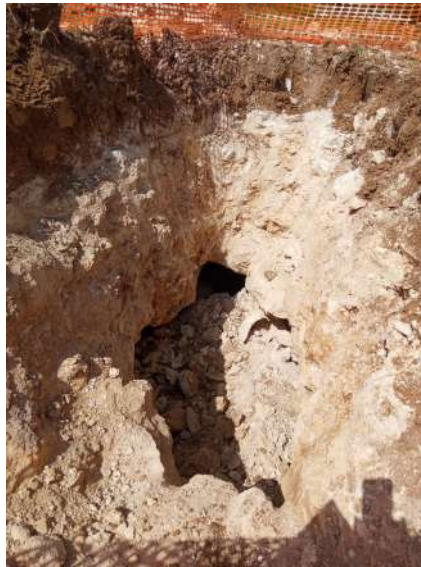
Effondrement survenu au lieu-dit « Les Courtines »
