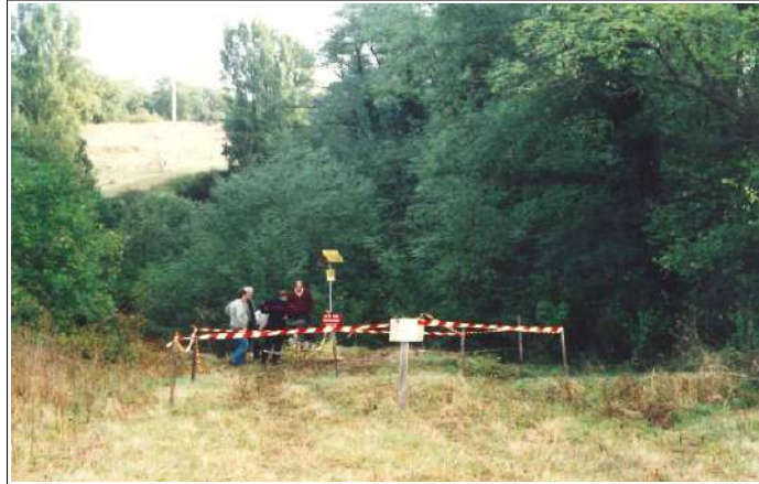
Apparition d'un fontis sur la parcelle AD177 au droit du gazoduc GSO.
