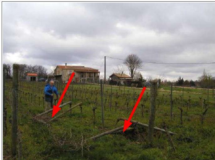
Vue des deux fontis de 2007 protégés par des barrières.
