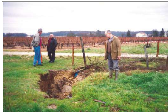
Effondrement et affaissement de janvier 1996 en limite communale avec Saint-Quentin-de-Baron.
