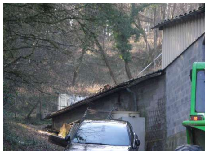
Hameau du Garon, un glissement de terrain s'est déclenché en pied de versant et a atteint un hangar. On distingue quelques arrachements au centre de la photo. Les arbres inclinés attestent également de l'instabilité du terrain.
