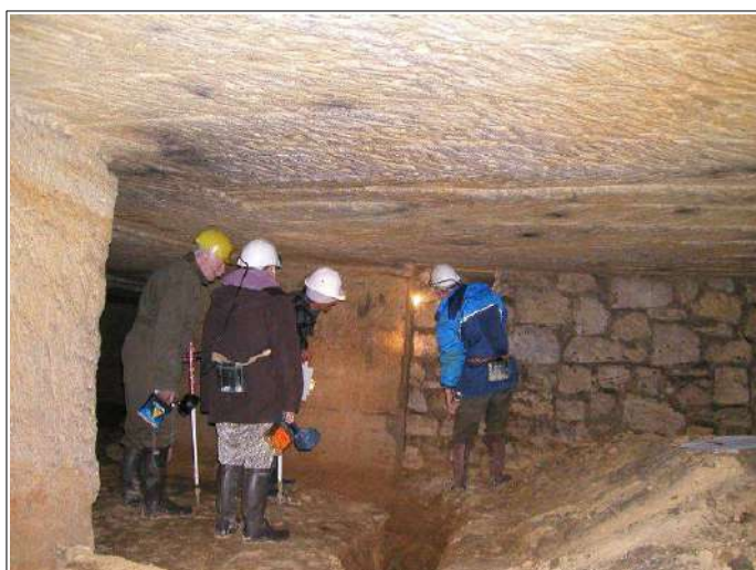
En sous-sol, approche de la zone effondrée (zone barrée par un mur en pierres maçonnées).
