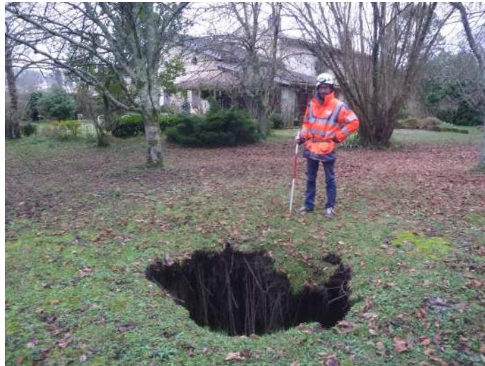
Fontis du 27 janvier 2018, lieu-dit « Sayes ».
