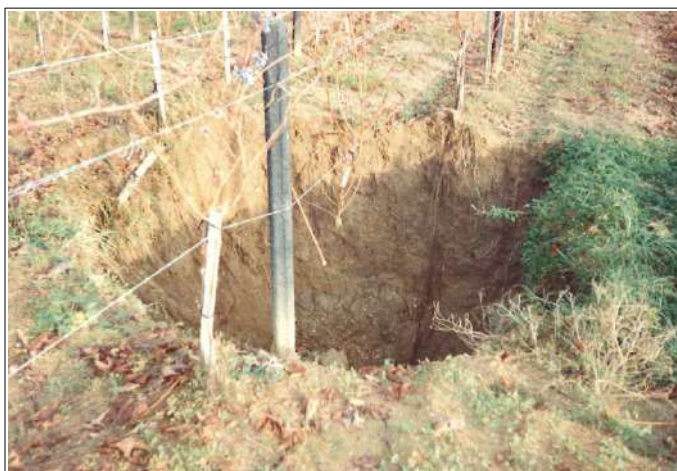
Autre fontis dans une vigne située à proximité du stade (1991 et 2001).
