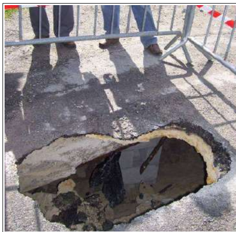
Fontis survenu sur la voie communale n° 17, on notera la faible épaisseur de cerveau de la carrière (environ 70 centimètres).
