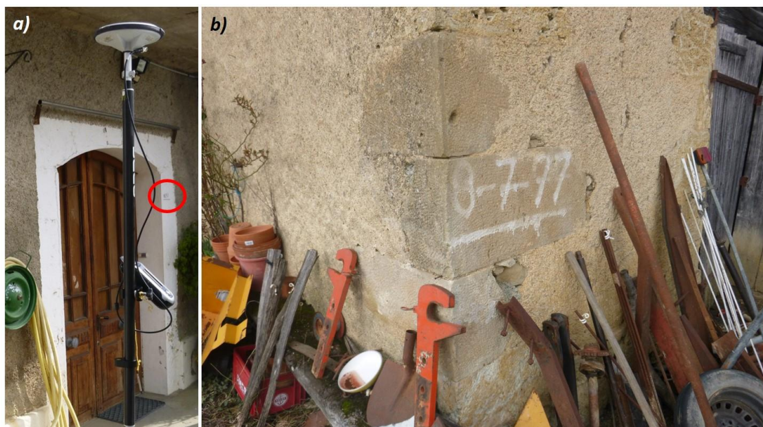
Exemples de repères de crue datant de juillet 1977 : a) repère gravé sur la porte du moulin d'Ornezan et b) repère marqué sur un mur, commune de Boucagnères (Source AGERIN).
