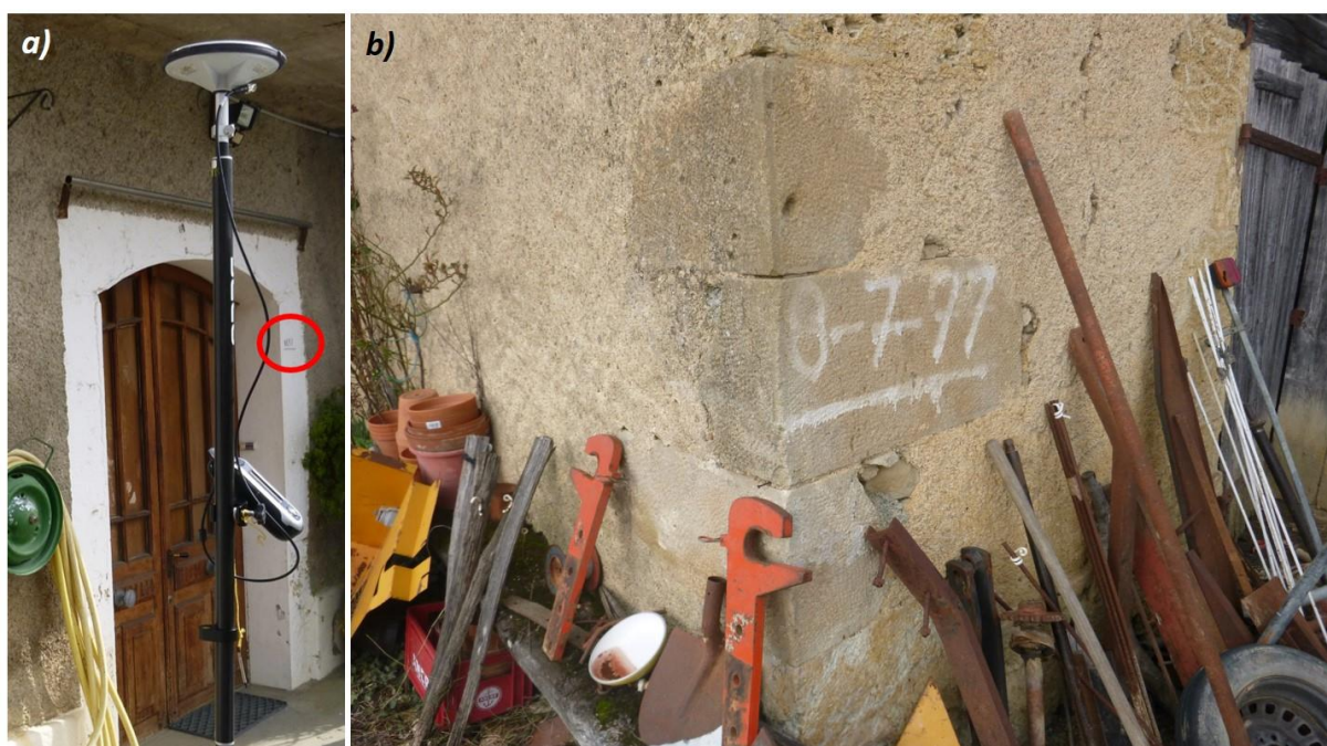
Exemples de repères de crue datant de juillet 1977 : a) repère gravé sur la porte du moulin d'Ornezan et b) repère marqué sur un mur, commune de Boucagnères (Source AGERIN).
