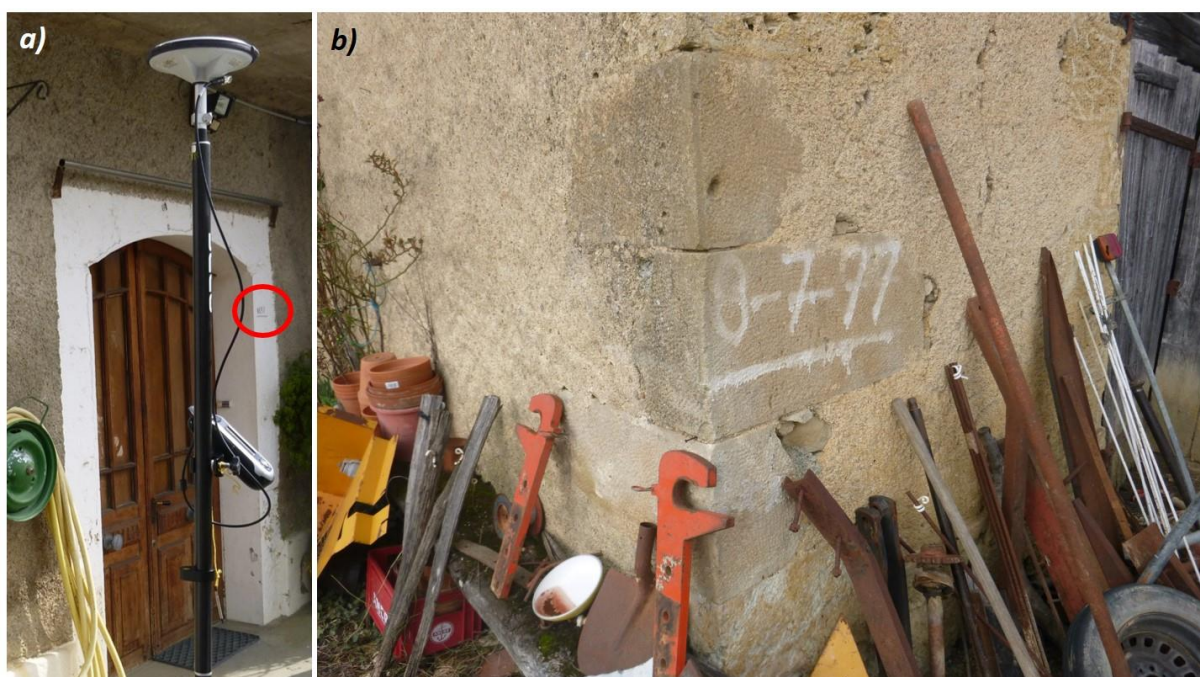
Exemples de repères de crue datant de juillet 1977 : a) repère gravé sur la porte du moulin d'Ornezan et b) repère marqué sur un mur, commune de Boucagnères (Source AGERIN).
