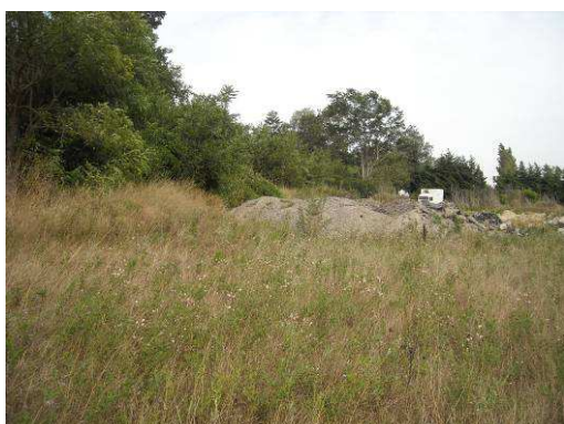
Aperçu de la digue en rive droite de l'Hers, à l'amont immédiat de la bretelle de l'A65
