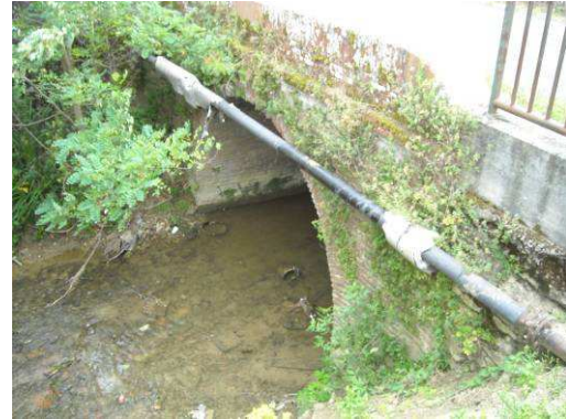
Pont de la route menant à la Bourdette, sur le Marès
