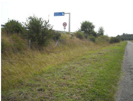
Remblai de l'A65
