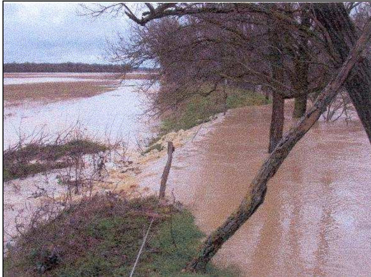
Photo n° 2 : Commune de Saint-Lys, au niveau du lieu-dit « la Tourasse ». La photographie montre la crue du 4 février 2003 passant par dessus la digue (photo M. Jean PIERRE).
