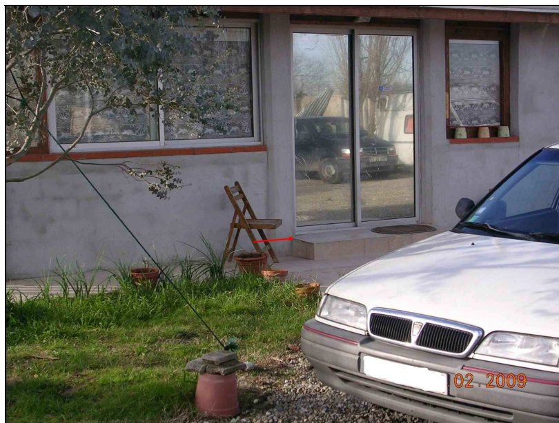
Photo n° 1 : Commune de Lherm, RD 43 au lieu-dit Palaix (Les Escassious). Lors de la crue de 1980, l'eau est arrivée au niveau de la marche de la porte d'entrée de la véranda chez Mr. Gomis. Il y avait 0.40 m d'eau.
