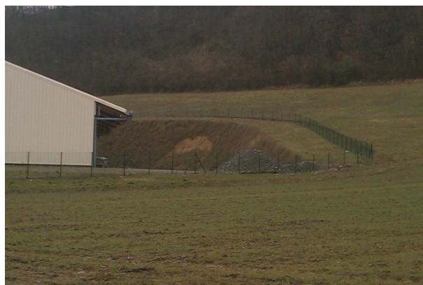
Exemple de glissement de talus (Gensac-sur-Garonne).
