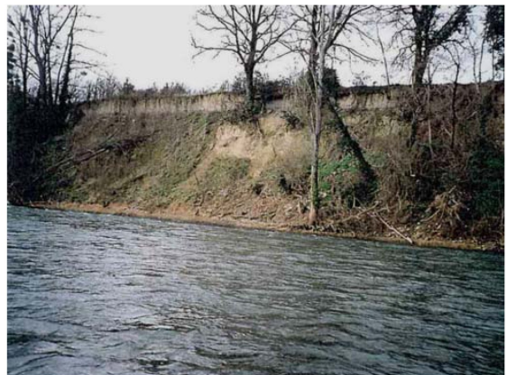
Fragilisation des dépôts alluviaux en crête Avenue Henri Peyrusse (avant urbanisation, 1996)
