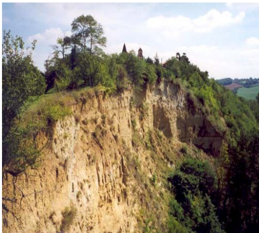
Commune de Clermont-le-Fort - 2004 Escarpement principal (vestige d'un glissement massif du versant dominant l'Ariège vers 1915)
