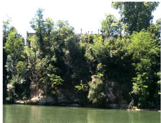
Dégradation différentielle des falaises fluviales Chemin du Moulin de la Garonne
