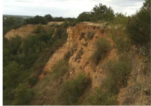
Parois molassiques actives (écailles instables), recul progressif - Cirque de Saint-Marcet
