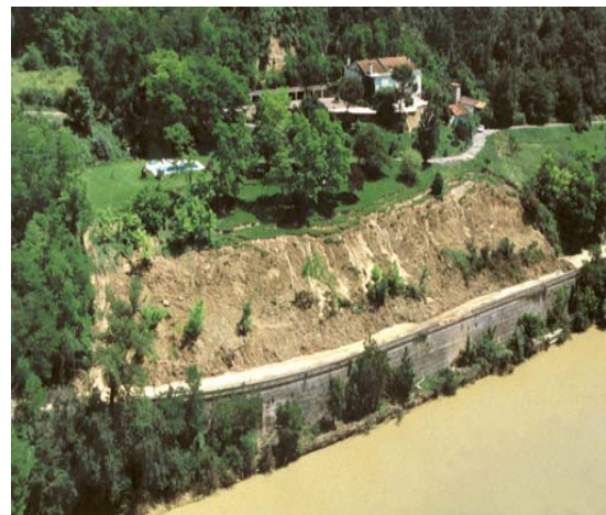
Commune de Vieille-Toulouse - 1992 Bourrelet d'un glissement de masse
