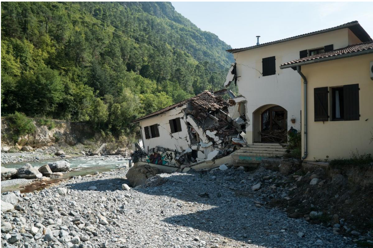
Exemple de dégâts sur un cours d'eau torrentiel © Alexandre-Reza Kokabi/Reporterre
